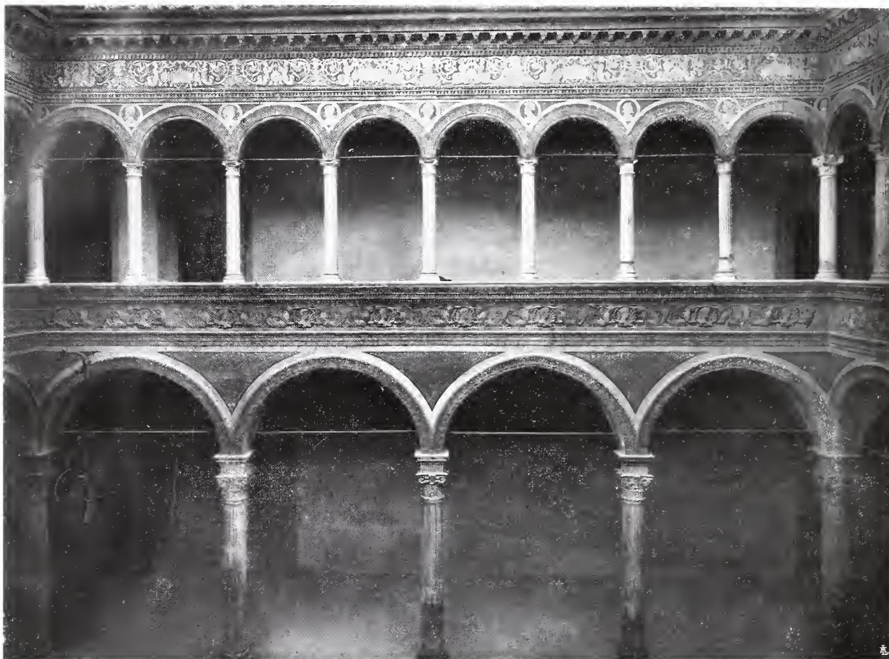
BOLOGNA - Palazzo Bevilacqua - Prospetto a sud dopo il restauro.
